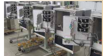
Montaje de Gabinete tipo II
