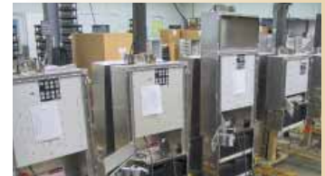
Montaje de Gabinete tipo III
